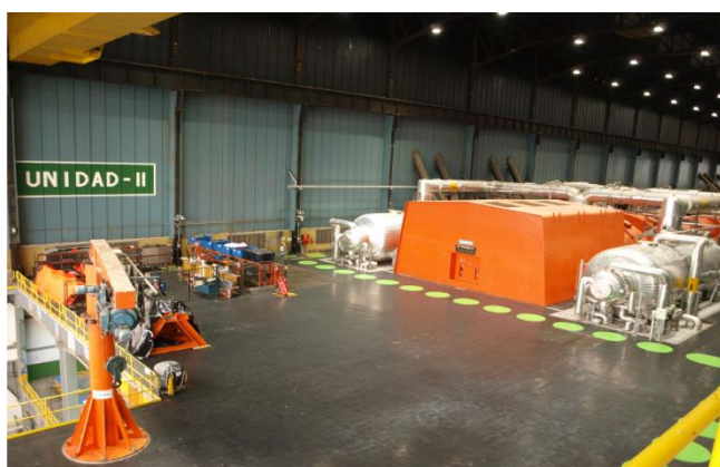
Edificio de Turbinas +14,60 de U-II
